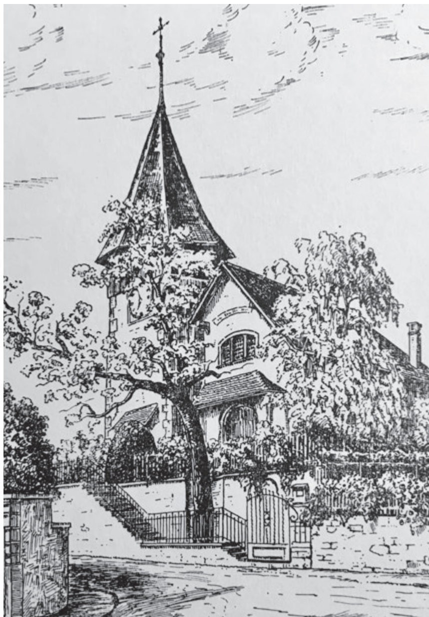
Ref. Kirche Sierre-Siders, erbaut 1905, Baukosten Fr. 25 000.
